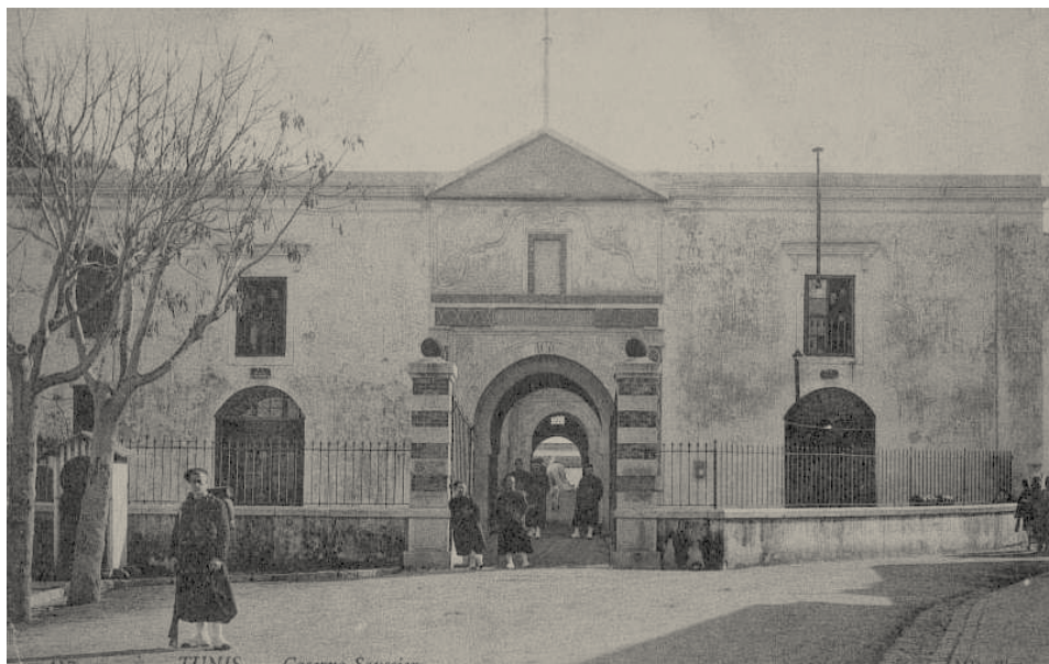
■ Caserne du 1er régiment (birinji alay) construite par Ahmed Bey et située au Morkadh, faubourg de Tunis, affectée sous le protectorat au 4e régiment de Zouaves sous le nom de caserne Saussier
